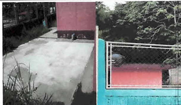
Foto 4: Mantenimiento de terraza y mezclón de baños.
