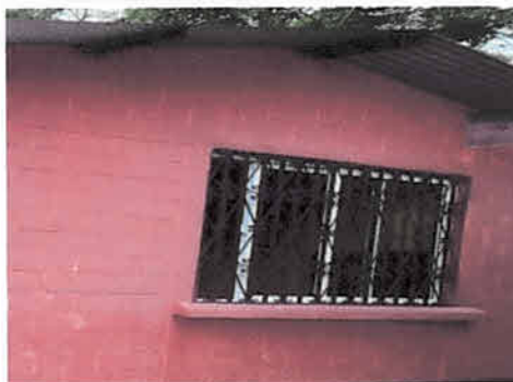
Foto 2: Colocación de ventanas de PVC.
