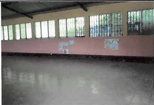
Foto1: Colocación de piso cerámico.
